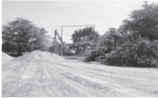
除染工事（中学校）
