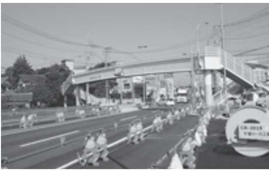
工事中の白山交差点（10月）
