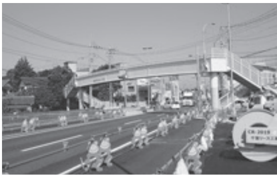
工事中の白山交差点（10月）
