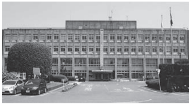
昭和45年建築、49年増築(3・4階部分)の市役所本庁舎
