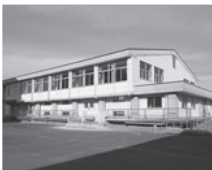
桜が丘小学校体育館
