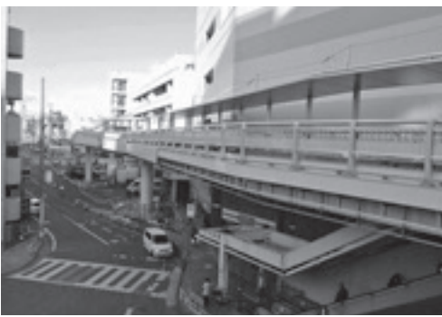
取手駅西口歩行者デッキ(1月)
