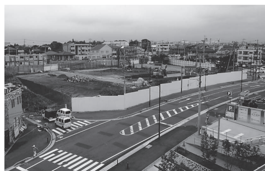
工事現場風景(7月)
