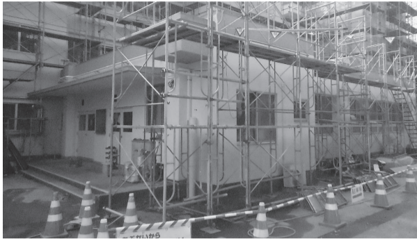
戸頭東小学校大規模改修の様子
