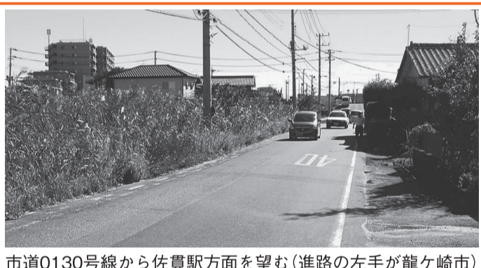
市道0130号線から佐貫駅方面を望む（進路の左手が龍ヶ崎市）
