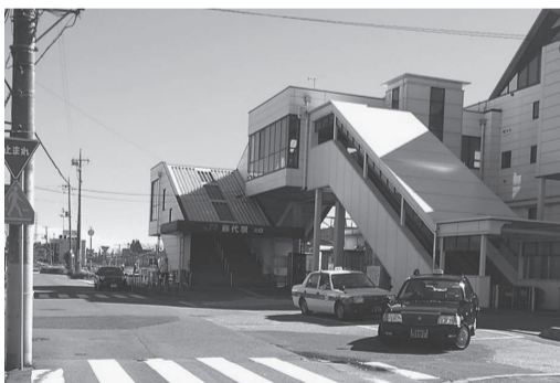
藤代駅北口(タクシー待機場)
