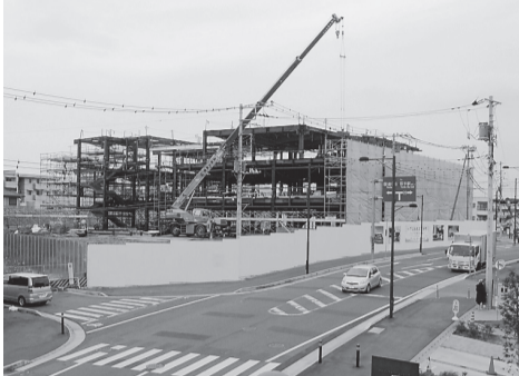
ウェルネスプラザ建設現場(1月)
