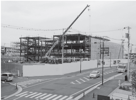
ウェルネスプラザ建設現場(1月)
