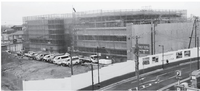
10月オープンに向けて工事が進むウェルネスプラザ(取手駅西口)
