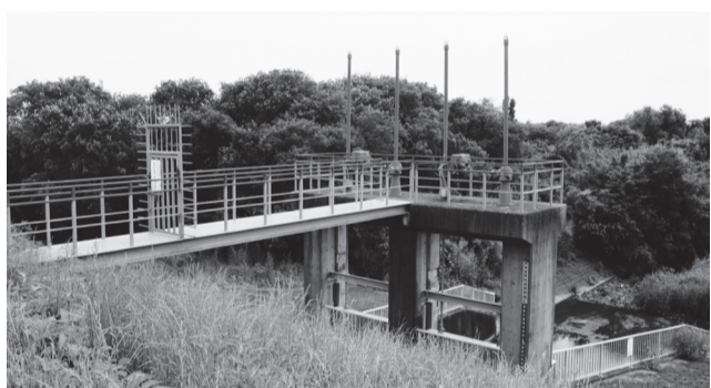
古戸樋管(取手市稲地先)
