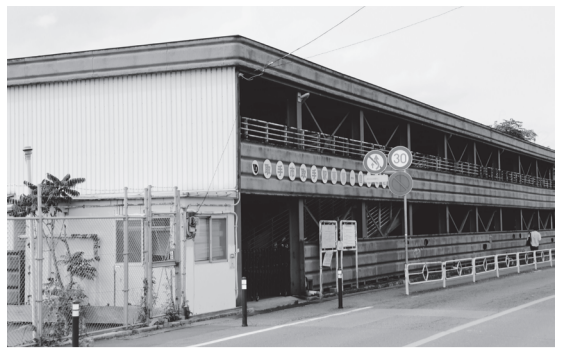
取手駅東第1自転車駐輪場
