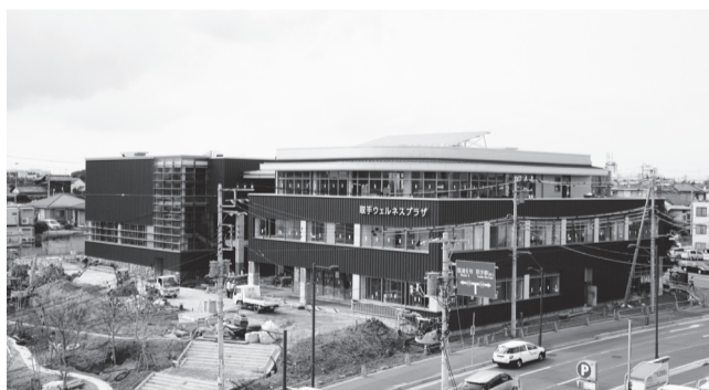
完成間近の取手ウエルネスプラザ(取手駅西口)
