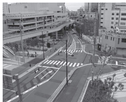
整備が進む取手駅西口
