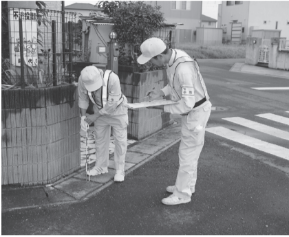
側溝点検の様子
