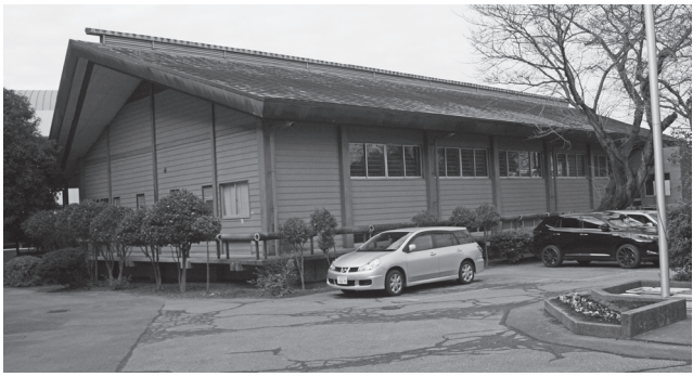
取手第二中学校武道場
