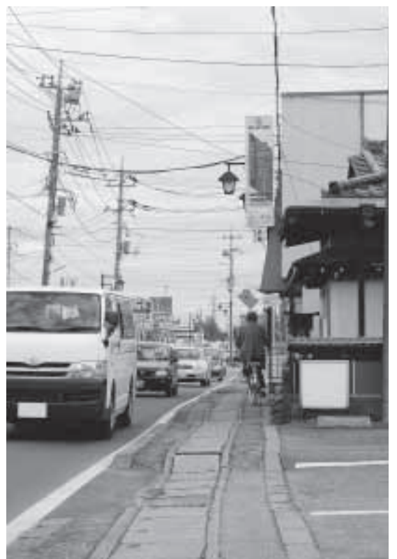
都市計画道路3・4・7号線（マスダ～ヤオコー間）
