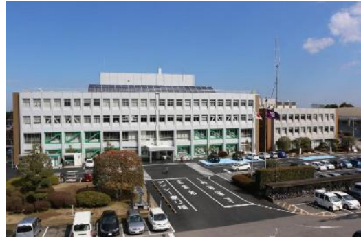
市本庁舎等に太陽光発電を設置
