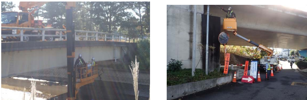
写真-3.1 点検の状況
