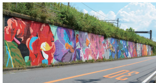
取手駅西口線路擁壁
