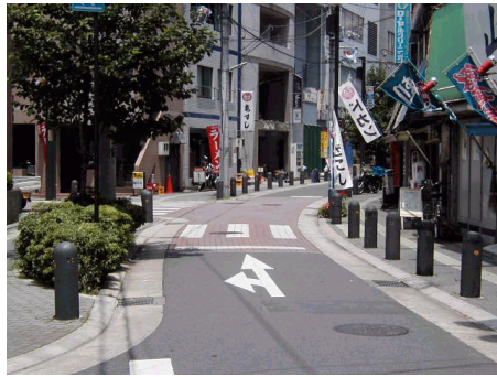
市道 4140 号（大師通り）
