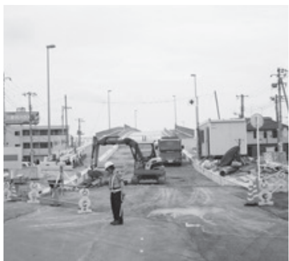
建設工事が進む中内大塚線の跨線橋
