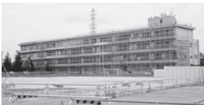
耐震化工事中の藤代小学校
