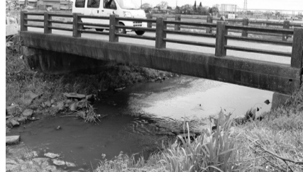
市内河川に架かる橋
