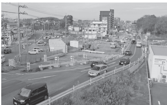
国道294号線 白山八丁目交差点
