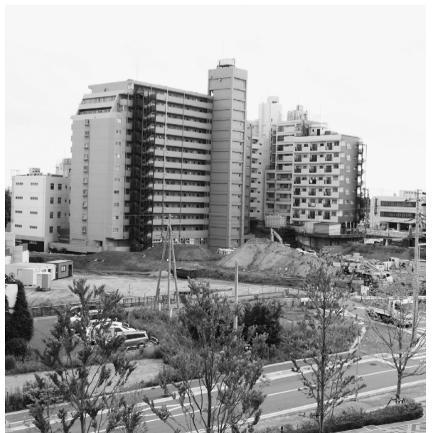
取手ウェルネスプラザから、取手駅西口のA街区や南部地区方面を望む。造成や道路整備が進んでいる。
