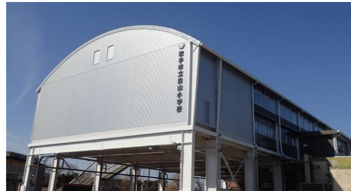
長寿命化改良工事(第1期)後の白山小学校体育館
