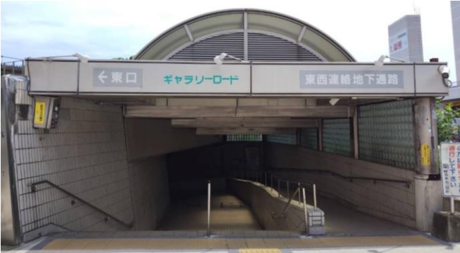
既存の東西連絡地下通路
