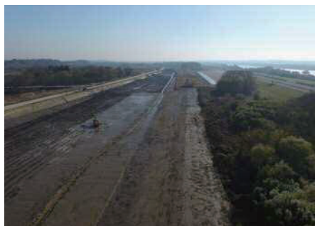
▲稲戸井調節池の掘削状況
