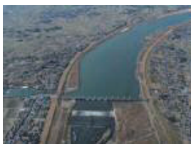
▲利根大堰を下流から望む
