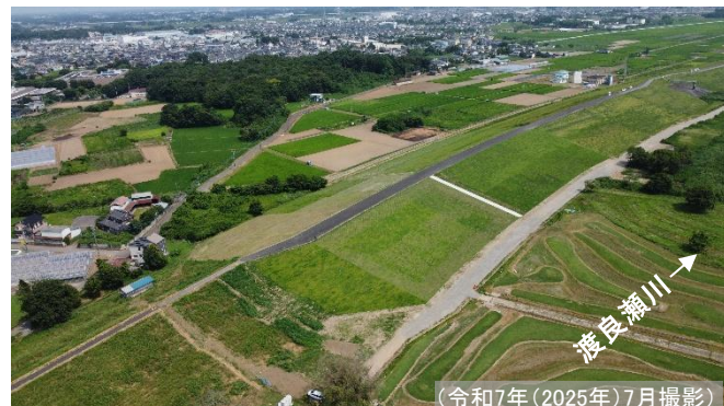
川表、裏断面拡幅・堤防かさ上げ状況(茨城県古河市新久田地先)
