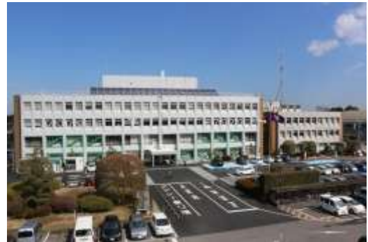
市本庁舎等に太陽光発電を設置
