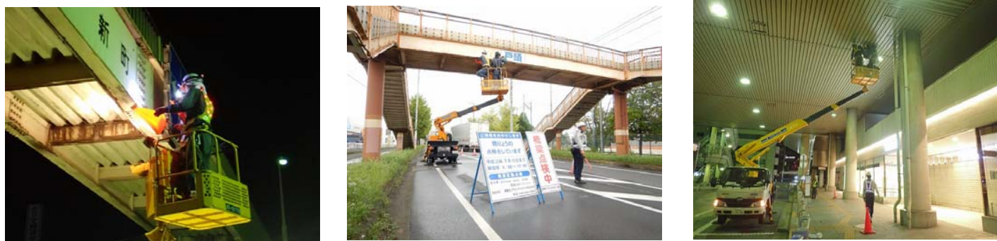
写真3-1. 横断歩道橋点検状況
