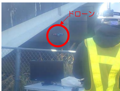
写真-5.1 新技術(ドローン)による点検事例（北浦川大橋）
