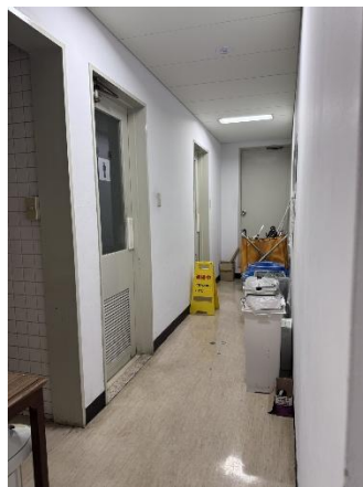
議会棟2階(トイレ出入口)
