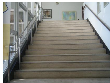
議会棟(通路階段)
