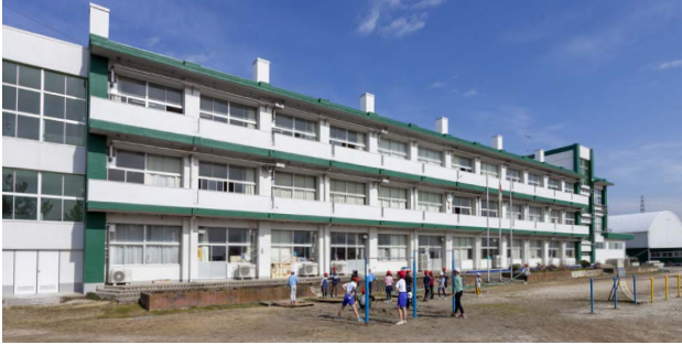
大規模改修工事後の久賀小学校
