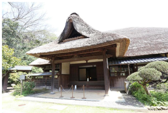
旧取手宿本陣染野家住宅の主屋正面
