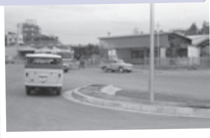
写真⑤西口木造駅舎(40年代前半)
