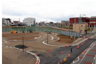
ロータリー出入り口(取手ウェルネスプラザ側)
