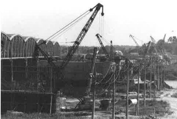
大利根橋建設風景（昭和46年）（取手市所蔵）
