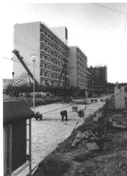
戸頭団地建設風景(昭和50年)(取手市所蔵)
