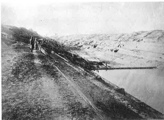
工事中の利根運河 (所蔵、写真提供 流山市立博物館)
