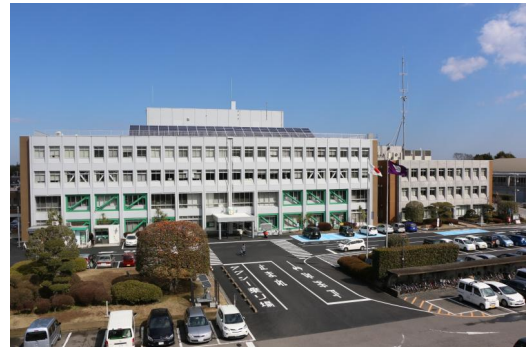
市本庁舎等に太陽光発電を設置
