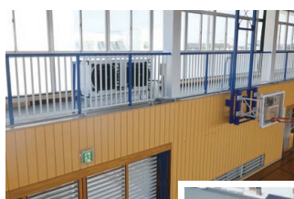
▲宮和田小学校 体育館
